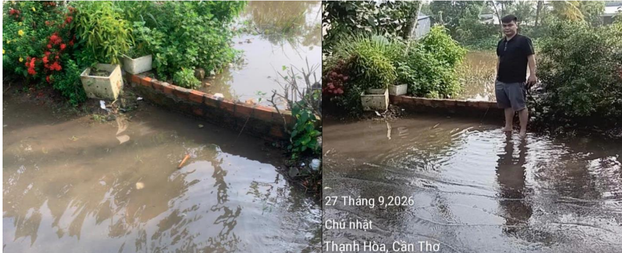
Hình 9. Hình ảnh tràn bờ bao thuộc ô bao Khu vực 5 (mã PH025), thuộc xã Thanh Hòa, huyện Phụng Hiệp, tỉnh Hậu Giang (cũ) trong kỳ triều cường cuối tháng 9 do cán bộ đoàn công tác của Viện chụp lại vào lúc 8h00 ngày ngày 27/9/2026
